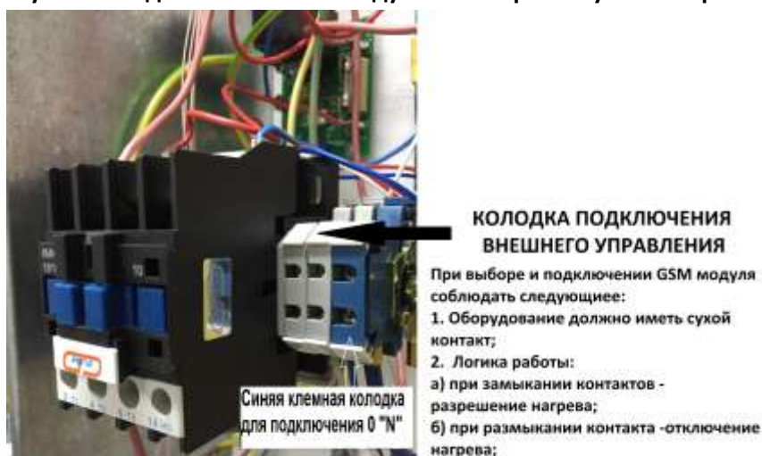
Рисунок 9. Подключение GSM модуля к электродотлу РЭКО серии ПМ
