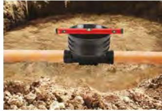
2. Установить днище (кинету) на дне траншеи (помня о проверке уровня и наклоне дна на уровне 1,5%), присоединить к нему канализационные трубы, а затем засыпать ее приibl. на 10см выше уровня трубы, чтобы предотвратить перемещение днища (кинеты).
