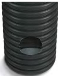
1. На требуемой высоте в подъемной трубе высверливаем отверстие и очищаем его от заусеницев,
