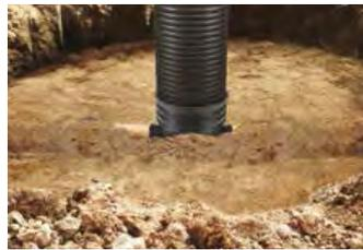
4. Удалить загрязнение с днища (кинеты). Средством для скольжения смазать изнутри днище (кинету) и уплотнение на подъемной трубе, и установить трубу в раструбе днища (кинеты). Подготовленную таким образом днище (кинету) засыпать легко уплотняемым грунтом. Одноразовый слой насыпи не может превысить 30 см.
