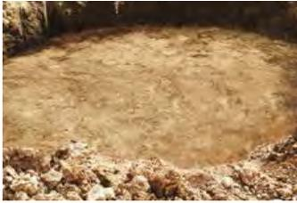
1. Из траншеи под установку колодца следует удалить большие и острые камни и подготовить подсыпку (мин. 10 см толщины) из крупнозернистого песка.
